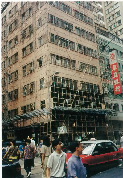
本會莊士敦道50號樓宇進行修葺工程。
