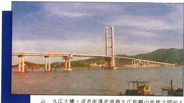
△ 九江大橋。這是座落在南海九江和鶴山沙坪之間的大型公路橋樑，橋長1682.4米，寬16米。該橋由我國自行設計和施工，1985年9月底動工興建，工期30個月。
