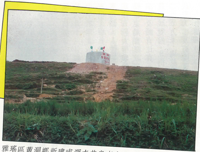
雅瑤區黃洞鄉新建成深水井自來水之山頂貯水塔，水壓可達四層高樓宇。
