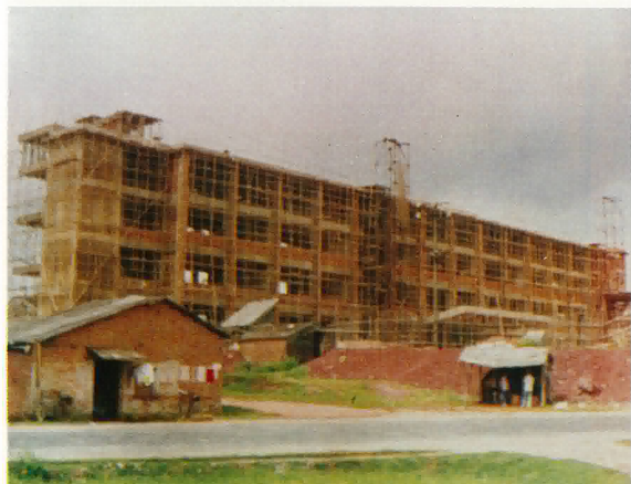
在建設中雅瑤區中學教學大樓工地。
