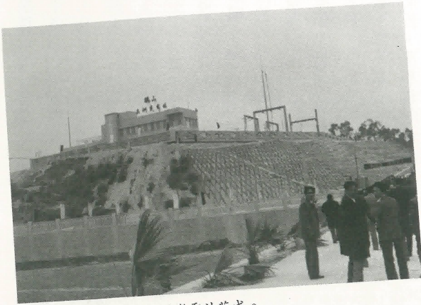
1984年新建鶴山縣杰洲變電站落成。
