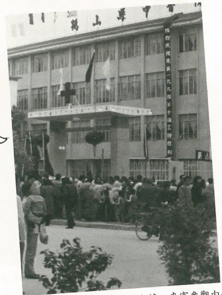
新建落成之鶴山縣中醫院大樓。來賓參觀內部設備。
