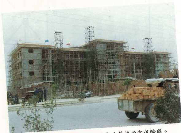
鶴山人民醫院「李一謬大樓」門診部建築接近完成階段。
