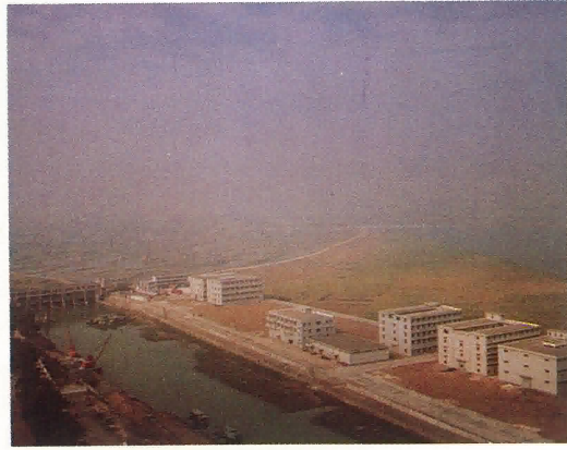
鶴山工業大廈22層鳥瞰加固之沙坪大堤（右）及鶴山水閘（中）。
